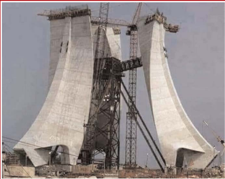
صورة لمقام الشهيد .. "رمز" الجزائر العاصمة وهو في طور البناء
